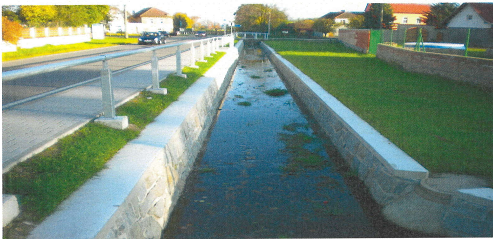
Tvrzický potok – opěrná zeď – oprava po povodních
